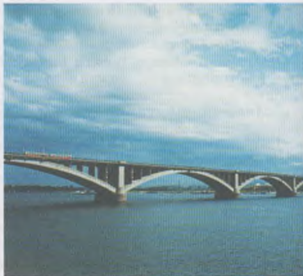
Рис. 115. Мост через реку Енисей
